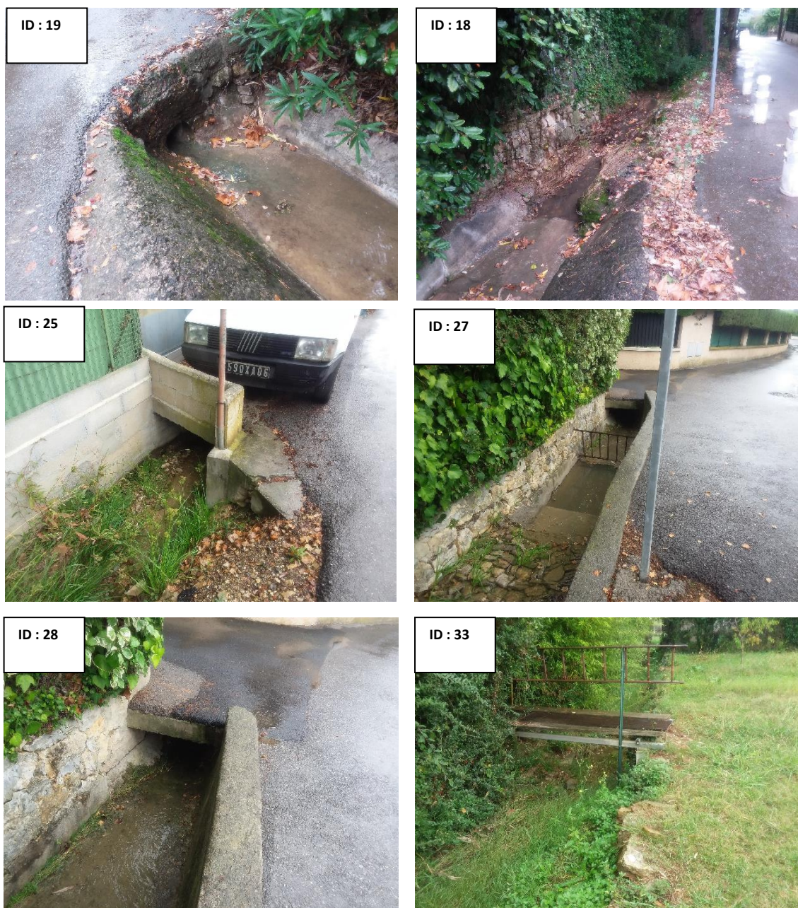
Figure 19 : Photographies le long du linéaire amont du Colombier – secteur Camp Lauvas issues des investigations terrain sur le Colombier. Succession de passages enterrés et à surface libre
