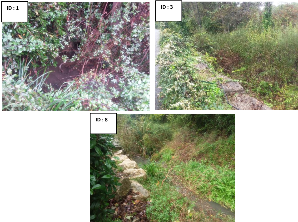
Figure 18 : Photographies le long du linéaire à surface libre du Devins issues des investigations terrain
