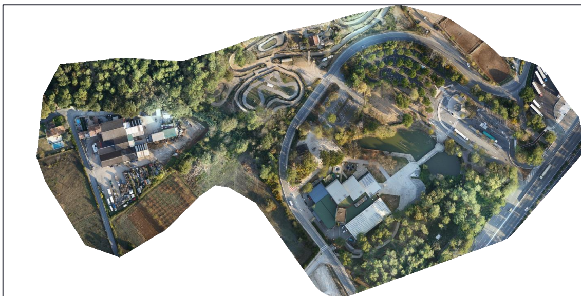
Figure 35 : Vue globale du relevé photogrammétrique sur Bréguières
